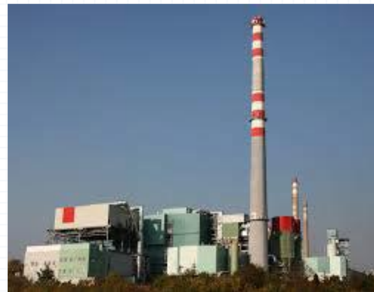
Constructions Industrielles de la Méditerranée, Vélizy, F / CONSISTERA s.r.o., Brno, CZ Odpadové hospodářství Brno
