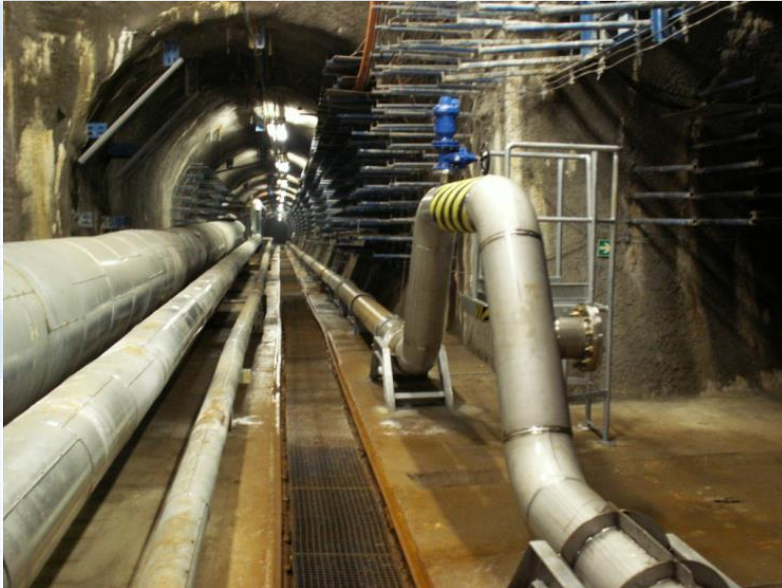
Statutární město Brno, Bratislavská Rekonstrukce kanalizace a vodovodu
